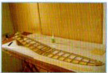
Une fois la première demi-aile réalisée et avant de mettre le coffrage supérieur, on assemble dans la foulée l'autre demi-aile.
