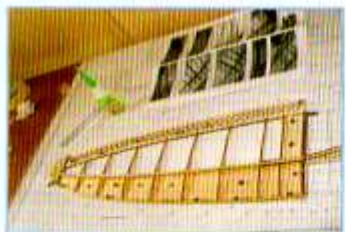
Des aimants sur un chantier revêtu d'une plaque d'acier maintiennent fermement les pièces pendant le collage.
