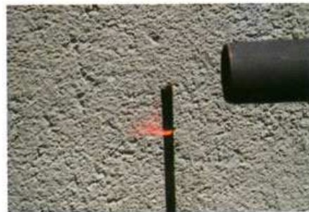
22) L'extrémité du jonc de carbone (ou de fibre de verre) est brûlée au jaluveau pour retirer la résine.
