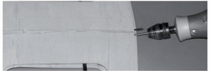
Percer chaque bord d'attaque \varnothing 2 mm et coller les tétons (47).
